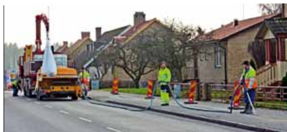
Man kan arbeta även genom större vägkorsningar utan nämnvärda hinder i trafiken. Det frästa spåret kan korsas utan att orsaka skador på vare sig fordon eller kanalisationsrör, och trafiken kan omedelbart släppas fram.
